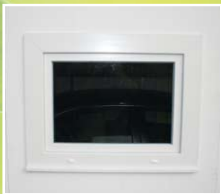
Neues Dreh-/Kippfenster mit Isolierglas
